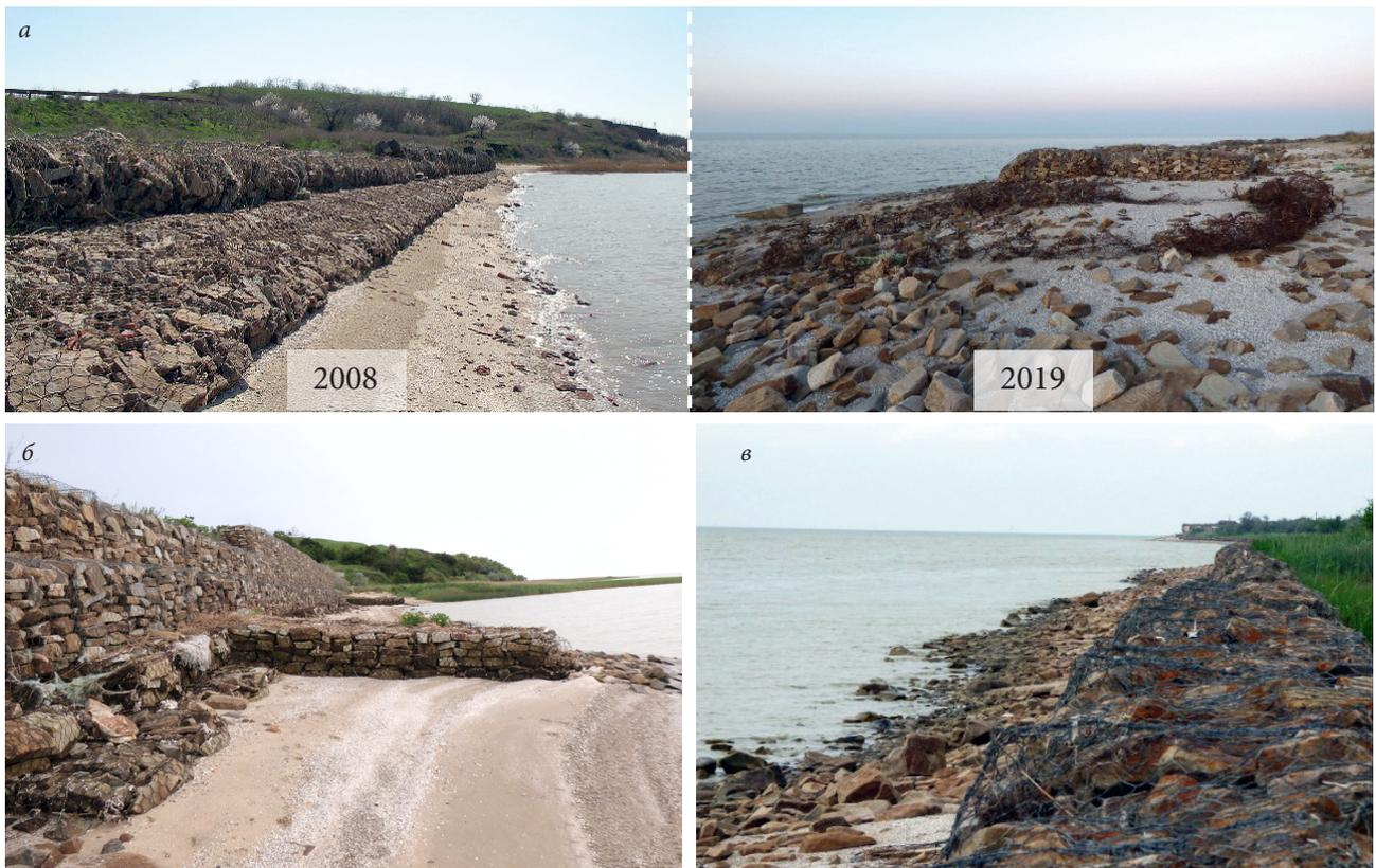
Рис. 2. Эффективность работы берегоукрепления на Чумбурской косе: а) размыв тела косы за берегоукреплением; б) современное состояние прикорневой части; в) разрушенное берегоукрепление в виде стенки из коробчатых габионов
