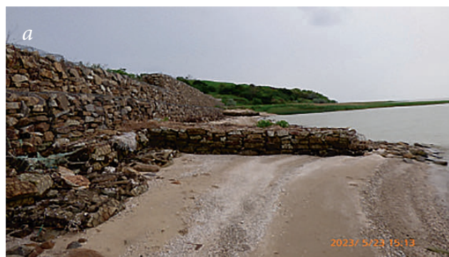
Рис. 10. Берегозащита прикорневой части Чумбурской косы: а) современное состояние, б) состояние коробчатых габионов 2018 г.
